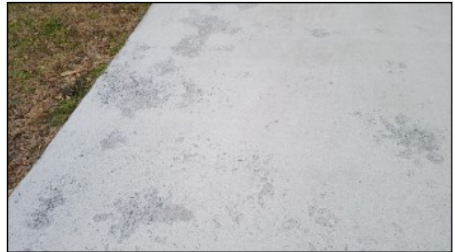
Spalling
